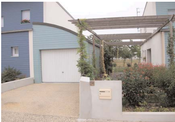
Détail sur les accès, Saint-Herblain (44)
