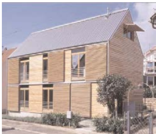
Construction à ossature bois, Stuttgart (Allemagne)
