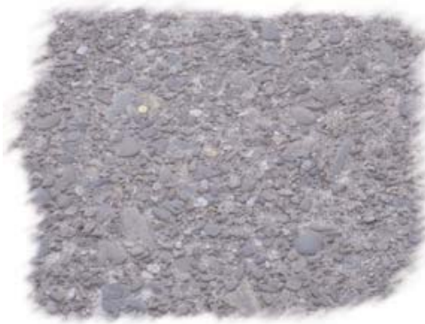
sol en béton désactivé
