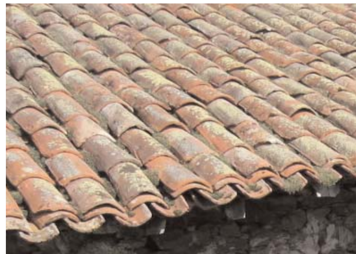
Toiture en tuile canal, Peyroutéoux, Burret
