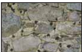
Maçonnerie réalisée avec des pierres et des scories de bas fourneaux, dépossédée de son enduit. Les scories permettent de renforcer la maçonnerie mais n'ont pas de but décoratif.
