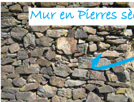
Intégration dans la maçonnerie de scories de bas fourneaux
