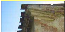
Corniche en brique foraine badigeonnée de chaux aérienne pour protéger son épiderme du gel.
