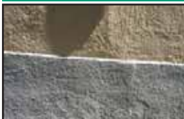
Décor réalisé avec un badigeon de chaux et pigments naturels.
