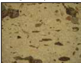
Enduit usé, réalisé à partir de chaux, de terre et de sable.
