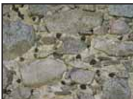
Maçonnerie dépossédée de son enduit, réalisée avec des scories de bas fourneaux permettant de renforcer la maçonnerie mais sans but décoratif.
