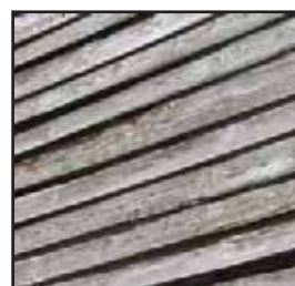
Bardage horizontal grisé
