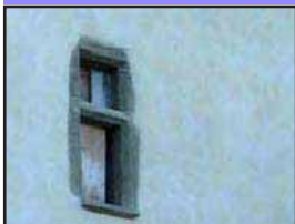
Enduit à la chaux naturelle, taloché fin.
