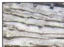
Bardage horizontal grisé
