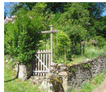
Mur bahut en pierres locales, agrémenté d'un grillage en fer et d'un portillon en bois.
