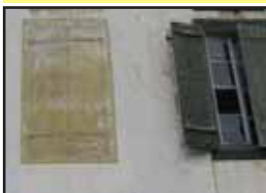
Trompe l'œil réalisé avec un badigeon de chaux et des pigments naturels.
