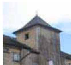
Couverture d'une tour, en ardoise taillée et calibrée artisanalement.
