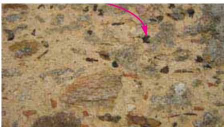
Intégration dans la maçonnerie de scories de bas fourneaux
