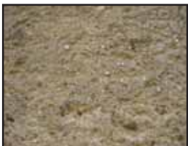
Enduit d'origine composé de chaux et de sable d'arènes granitiques.
