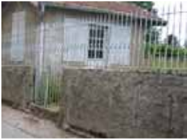
Mur bahut enduit surmonté d'une grille en fer.
