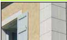
Décor peint réalisé avec un badigeon de chaux teinté avec des pigments naturels, donnant à la chaîne d'angle et à l'encadrement des ouvertures une allure de pierre de taille.
