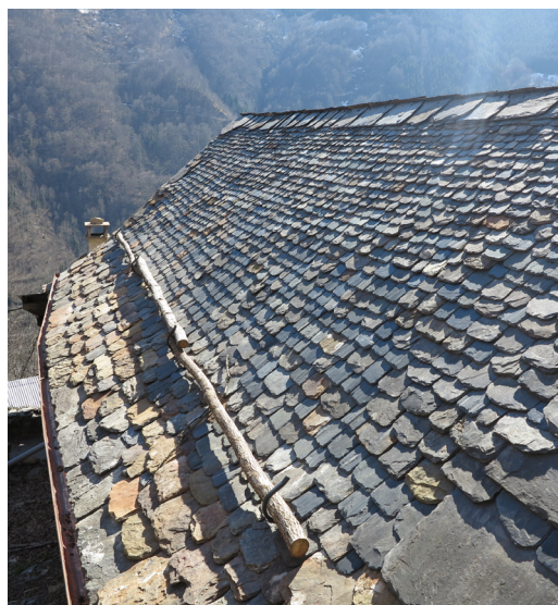
Toiture à Seix
