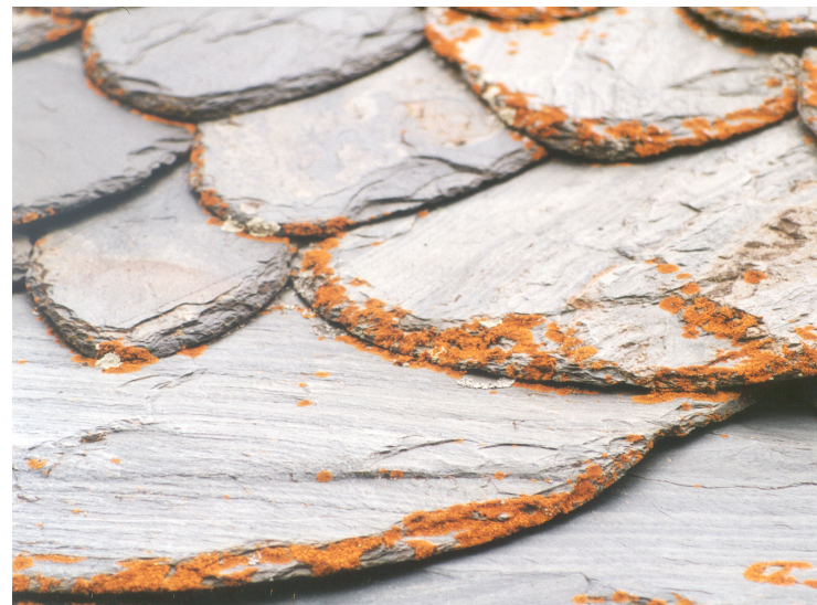
Détail d'ardoises et leurs épaufures* sur la face supérieure
