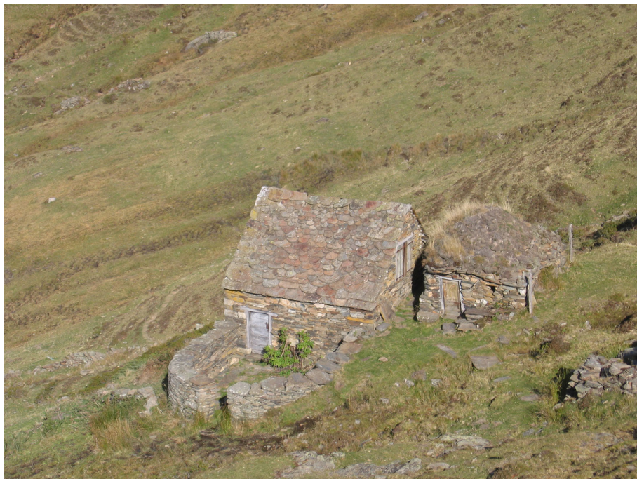
Les cabanes de Goutets (Le Port). La grange-étable (à gauche) est couverte par de la lauze clouée sur volige et la cabane pastorale (à droite) est couverte par de la lauze en tas de charge.
