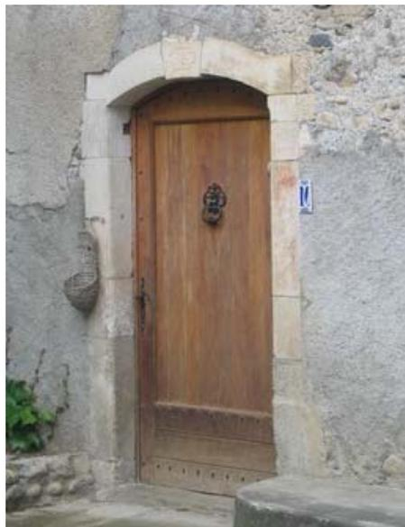
Pour les portes, quand les montants sont en bois, ils reposent sur des socles en pierre, afin d'éviter le pourrissement des montants.
