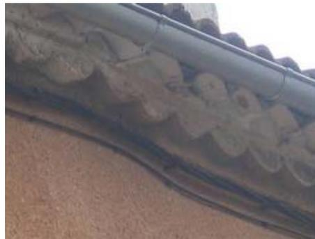
Il est intéressant lors de rénovation de façades de maintenir ces génoises, même si le côté esthétique prend le pas sur le fonctionnel. Une toiture pourvue d'une génoise n'est jamais équipée d'une gouttière.
