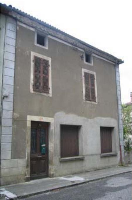
On retrouve des portes et des fenêtres de forme rectangulaire ou en arc surbaissé. Les encadrements des portes et des fenêtres peuvent être en pierre ou en bois.
