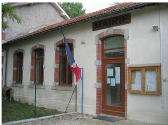
Les murs, recouverts d'un enduit ciment, sont agrémentés de chaînes d'angles en brique et pierre, ainsi que d'un soubassement porté en surépaisseur.
