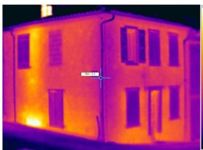
La caméra ne permet pas de voir à travers la matière mais rend visible l'accumulation et la déperdition de chaleur dans celle-ci. Par exemple, dans la photo ci-contre, on observe la présence d'une cheminée à travers la chaleur qu'elle dégage dans le mur. On peut aussi voir qu'une fenêtre a été comblée après la construction de la maison avec des matériaux plus isolants...
