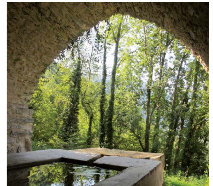
Restauration du lavoir de Gestières
