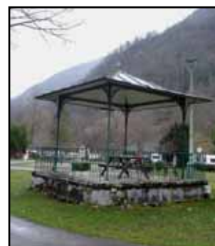
Photo 113: Kiosque d'Aulus les Bains avril 2007
