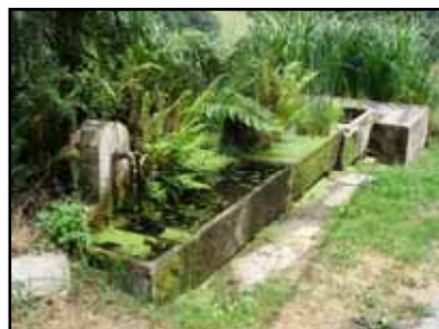
Photo 73: Saint-Martin de Caralp, Appropriation par la faune et la flore d'une fontaine-lavoir-abreuvoir Estrémé Flavie juillet 2006
