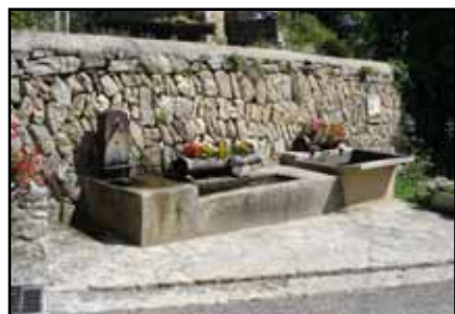
Photo 72: Ganac, fontaine en fonte-lavoir à ciel ouvert-abreuvoir Estrémé Flavie juin 2006
