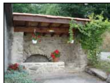
Photo 56: Serres sur Arget, hameau de Lux, puits sous une arche protégée par un auvent Estrémé Flavie juin 2006
