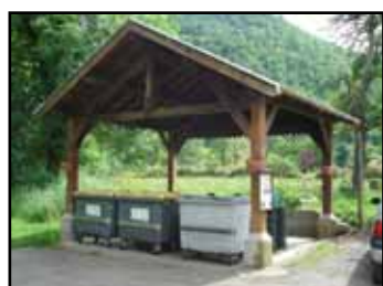
Photo 28: Moulis, Arguilla, lavoir reconverti en local poubelles mai 2007
