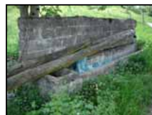
Photo 53: Saint-Girons, abreuvoir servant de lieu d'entrepôt mai 2007
