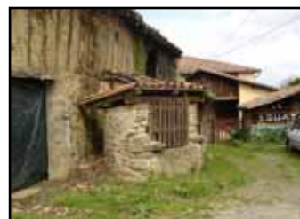
Photo 54: Lasserre, puits couvert juin 2007
