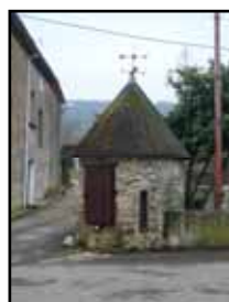
Photo 55: Les Bordes sur Arize, puits restauré avril 2007
