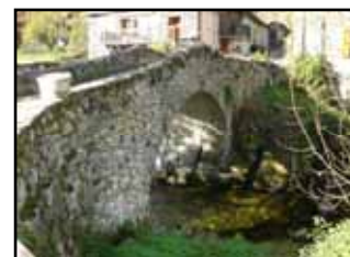
Photo 75: Pont à arche au Port octobre 2006
