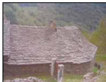
Photo 10 : Toiture en ardoise à pureaux dégressifs au Port Conseil Général 2006
