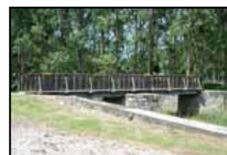
Photo 77: Passerelle en bois à Cazavet juin 2007
