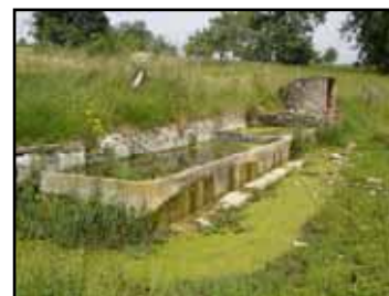
Photo 69: Tourtouse, puits-lavoir-abreuvoir juin 2007
