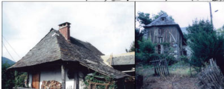
Dossier 160 : réfection de la toiture avec création de houteaux, ardoises de récupération Surface : 124 m 2
