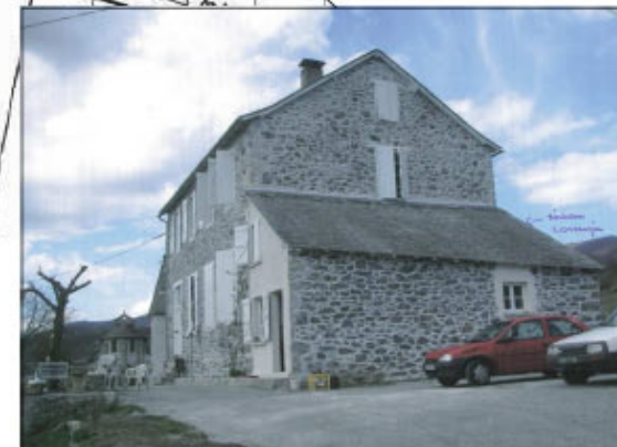
Dossier 169 : Mairie, réfection de la couverture de l'appentis Est de l'ancienne école communale Surface : 40 m 2
