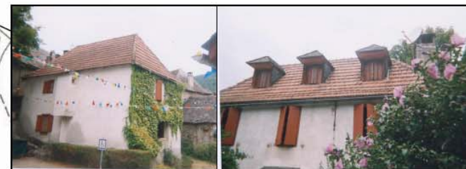
Dossier 118 : réfection de la toiture en ardoise Surface : 102m 2
