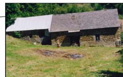
Dossier 81 : rénovation de la toiture Surface : 80m 2
