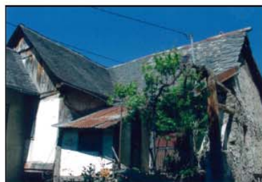
Dossier 131 : réfection toiture et création de 2 capucines Surface : 165m 2
