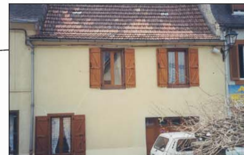
Dossier 90 : réfection toiture en ardoise Surface : 48 m 2
