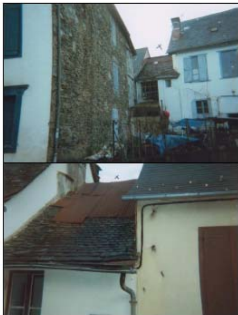
Dossier 69 : remplacer les tôles par de l'ardoise. Surface : 36 m 2
