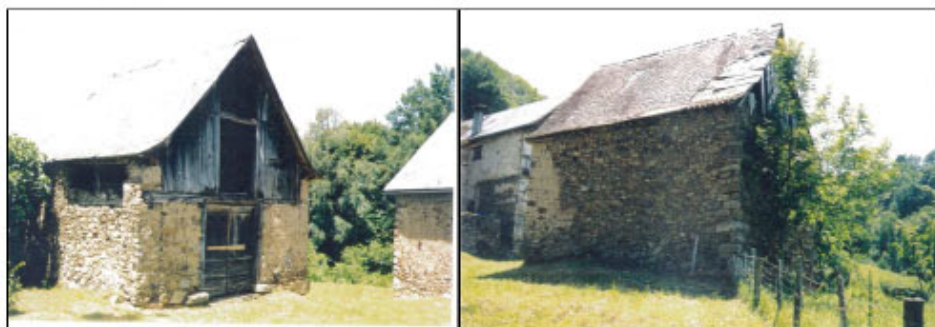
Dossier 78 : réfection de la toiture Est. (photo de droite Sud Est, photo de gauche Nord Ouest) Surface : 138m 2
