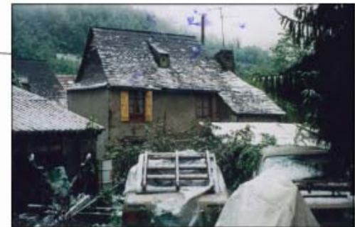
Dossier 110 : réfection d'une partie de la toiture (côté jardin) Surface : 50 m 2
