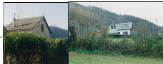
dossier 33 : le chalet de la croix, réfection de la toiture Surface : 74 m 2
