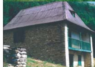
Dossier 117 : réfection de la toiture (remplacer la toiture bituminé type « onduline » par des ardoises) Surface : 135 m 2
