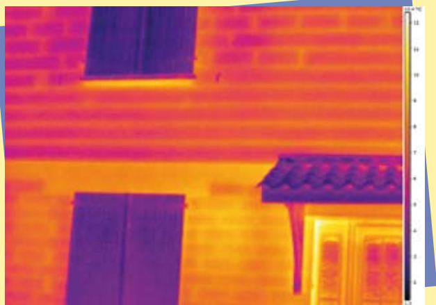
Photo d'une façade prise avec une caméra thermique
