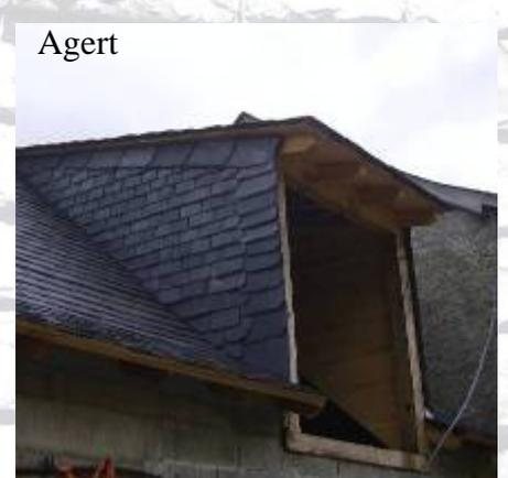
Ces éléments architecturaux sont traditionnels des habitations du Couserans. Les toitures des anciennes habitations comportaient peu d'ouvertures et celles-ci étaient de dimensions restreintes. Leur fonction était plus liée à l'aération qu'à l'éclairage pour cela leurs positions sur le toit peuvent être différentes.
