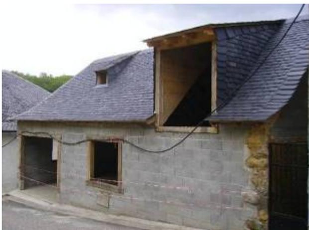
L'opération ardoise a permis la réfection de trois toitures. Une des toitures a été restaurée en respectant les caractéristiques des lucarnes propres à certaines granges.
