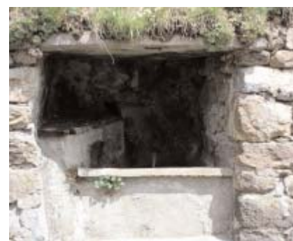
L'abreuvoir et le lavoir de Rogale, éléments insérés dans le mur de soutènement
