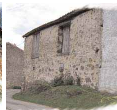
Mur postérieur d'une ferme enduit à la chaux
