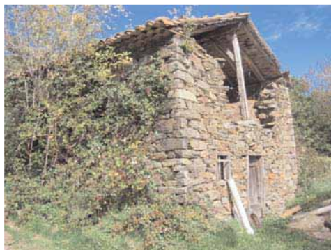
Grange, hameau du Courtal, commune de Burret
