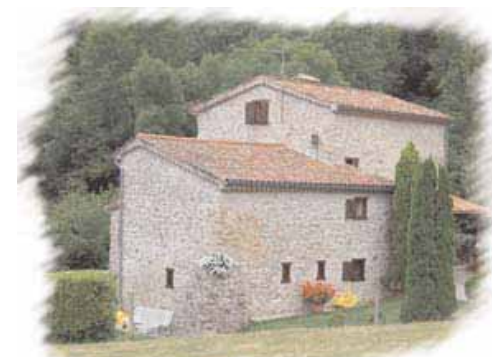
Façade postérieure, moulin de la Nation, Ganac
