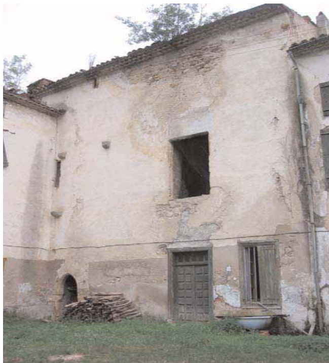
Ganac, partie la plus ancienne du château
