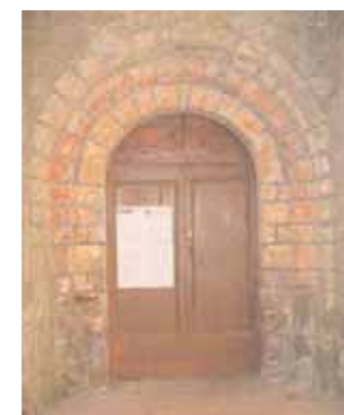
Porche d'entrée, église de Bénac
