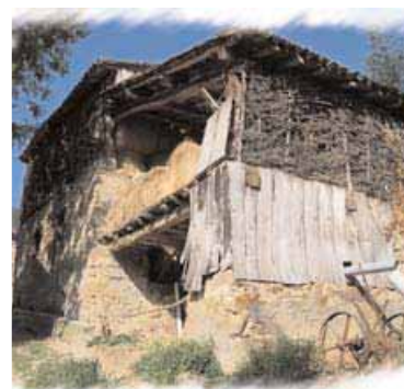
Bardage bois et branchages
