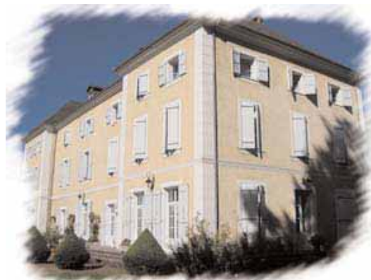
Façade principale du Château de Bénac
