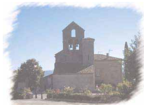
façade occidentale, église de Bénac
