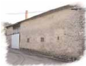
Ferme façades post. à Cos
