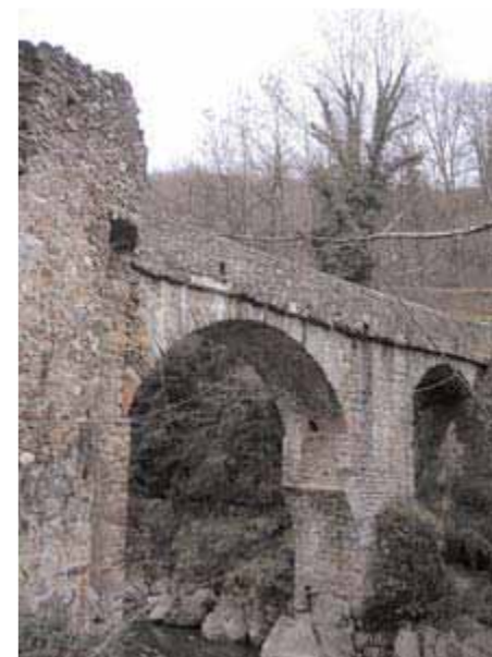
Le pont du Diable, Montoulieu
