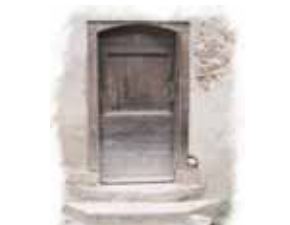
Porte d'entrée, ferme à Ganac
