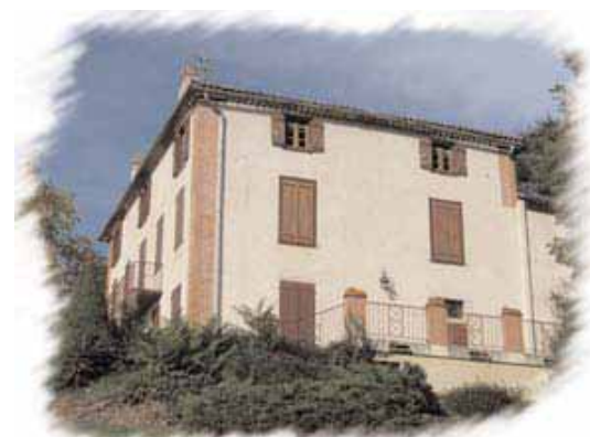
Façade principale et orientale, demeure de Caussou, Cos
