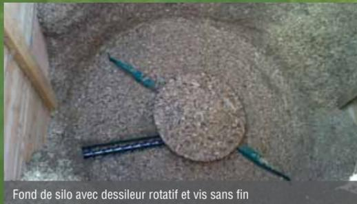
Grâce à une vis sans fin, les plaquettes sont acheminées automatiquement depuis le silo jusqu'au foyer de la chaudière.
