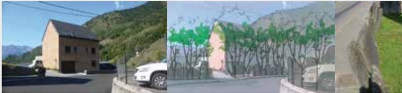
Réaménagement d'une limite parcellaire avec des ardoises sur champs (posées sur le côté le plus étroit).
