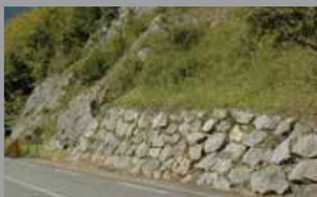
Enrochement dans la vallée d'Aspe (PNP). Même si la pierre utilisée est locale et que l'enrochement est proprement réalisé, il ne s'agit pas d'un mur de pierre sèche mais d'un ouvrage routier de soutènement.
