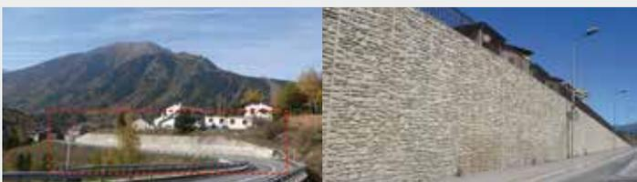
Ouvrages de soutènement en béton lisse à gauche, et en béton matricé à droite.
