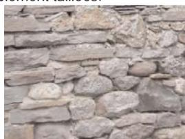
Outre le granit, le **schiste**, est également utilisé. Il est posé sous forme de plaques horizontales, comme pour le grès.
