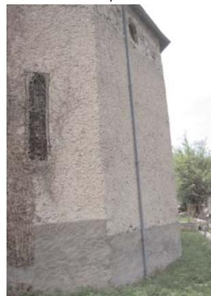
Quelques opérations d'entretien et d'embellissement sont à réaliser. Les murs doivent tout d'abord être enduits, travail déjà exécuté sur la façade occidentale. L'enclos doit être réhabilité, en préservant le mur de clôture et en rénovant le portail qui commence à se détériorer. Un aménagement plus général de l'accès et de l'environnement proche du monument doit être établi, en prenant en compte l'arbre de la liberté et la borne-fontaine.
