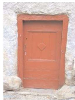
Comme la pierre, le bois est un matériau qui a toujours été utilisé. Dans les bâtiments traditionnels, on le trouve pour les **huisseries**, les **encadrements des ouvertures**, sous forme de **bardage** pour les granges, ou de garde corps pour les balcons.
