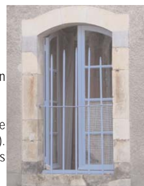
Ouverture en arc surbaissé
