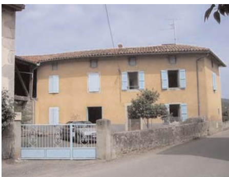
Une chaîne d'angle portée en surépaisseur de l'enduit
