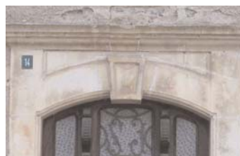
Porte d'entrée: linteau mouluré, clé, et décor de table sur le tympan
