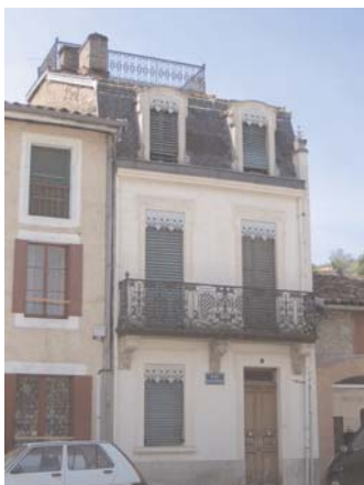
Maison avec toit à la Mansart
