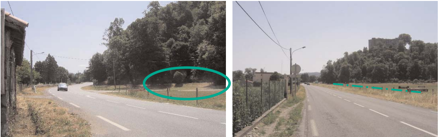
Plantation de massifs végétaux de taille moyenne pour ne pas boucher la visibilité tout en marquant l'entrée dans l'agglomération
