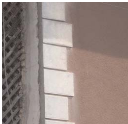
Une chaîne d'angle portée en surépaisseur de l'enduit
