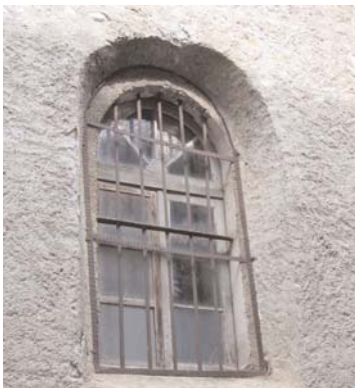
Ouverture en arc plein cintre
