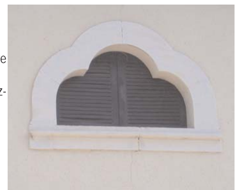
Ouverture trilobée en comble
