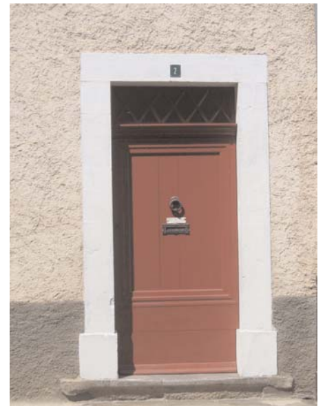
Une porte d'entrée à l'encadrement de pierre badigeonné à la chaux.
