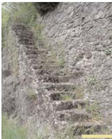
escalier en pierre
