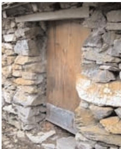
Appareillage en pierre calcaire et schiste
