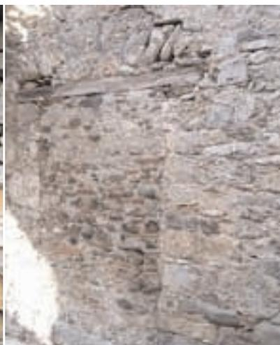
Appareillage en galets de granite et moellons de schiste
