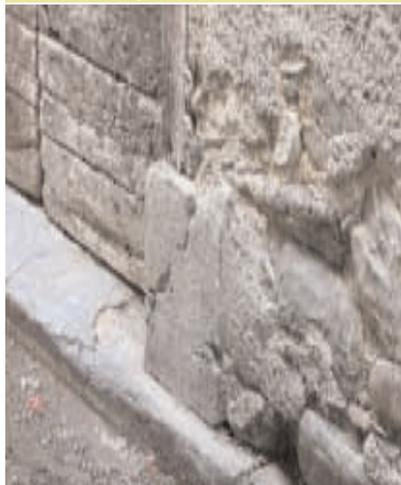
Socle en pierre calcaire, (protection remontées capillaires)
