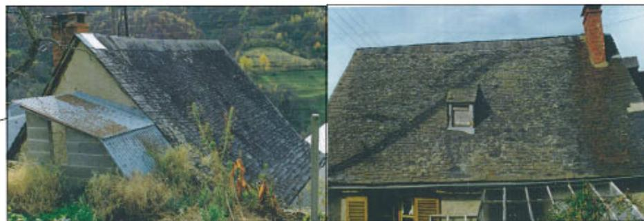
Dossier 47 : rénovation de la toiture avec remplacement de la lucarne existante par deux lucarnes de même style. Mais aussi, remplacement des tôles par des ardoises.
