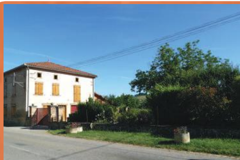
Entrée de bourg à Campagne-sur-Arize
