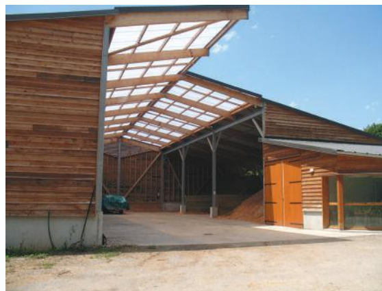
Ci-contre, une plateforme de séchage de plaquettes de bois en bois local
