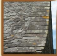
Toit en ardoises posées au clou à pureau dégressif
