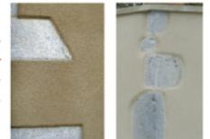
Si vous souhaitez laisser la pierre visible sur les granges (seuls édifices où la pierre était apparente), évitez la mise à nu systématique des pierres, que ce soit en creusant les joints ou en réalisant des bourellets d'enduit sur les pierres. Préférez un enduit, au mortier de chaux, à pierre vue qui vient à fleur de la pierre, il permet d'évoquer l'usure et la patine du temps (cf.ci-contre).
