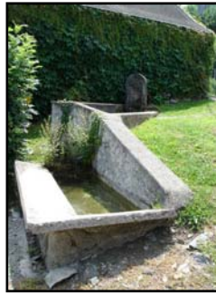
Fontaine-lavoir-abreuvoir construite selon la pente à Cérizols
