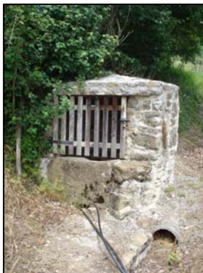
Puits couvert réhabilité
