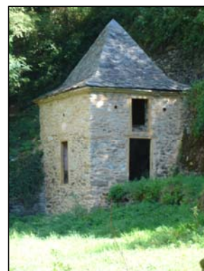
Gloriette en réhabilitation
