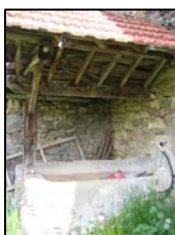
Lavoire privé d'une ferme à Cabus
