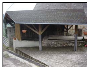
Fontaine-lavoir-abreuvoir réhabilitée dans le centre bourg
