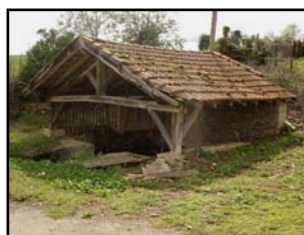
Lavoir couvert aux Baudis
