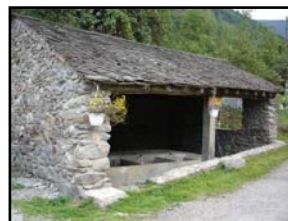
Lavoir avec un toit en lauzes
