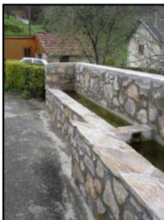
Fontaine-lavoir-abreuvoir réhabilitée à La Pause
