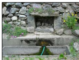
Abreuvoirs en béton...Une niche en pierre placée au dessus caractérise cet abreuvoir
