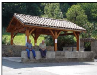
Lavoir couvert réhabilité
