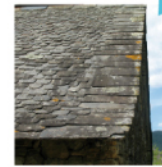
Toiture en ardoises à pureau dégressif
