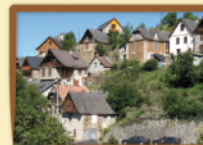
Faitage perpendiculaire à la pente (vallée de Bethmale)
