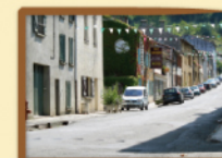
Alignement des façades le long de la rue
