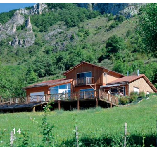
Maison ossature bois Vallée de Lesponne
