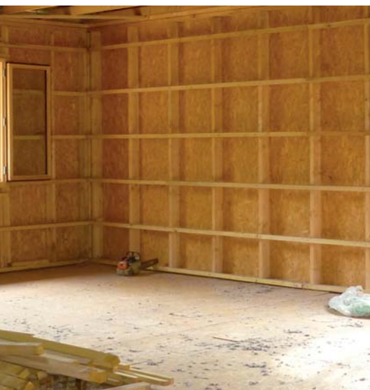
Ossature en attente de recevoir l'isolation Montgailhard
