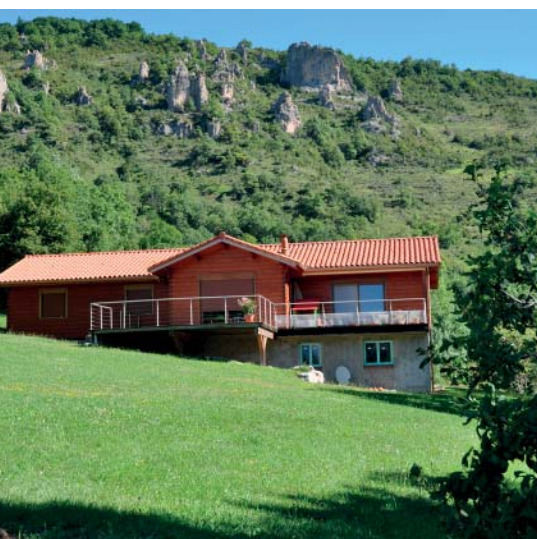
Maison ossature bois Vallée de Lesponne
