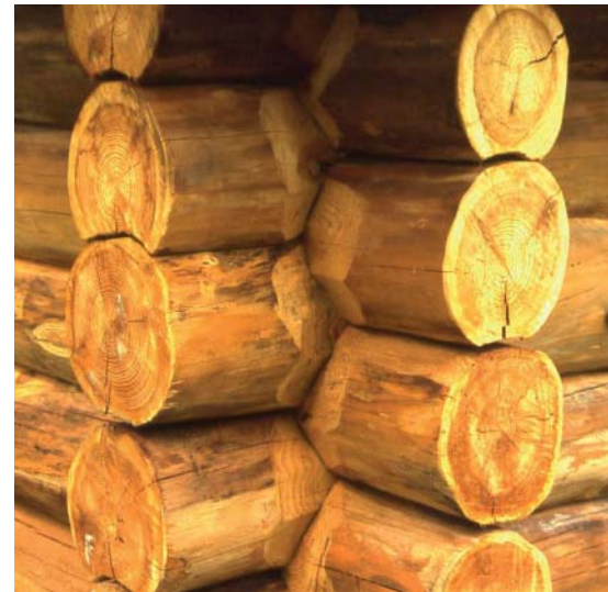
Détail angle de façade fustes
