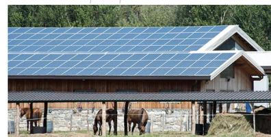
Bâtiment agricole : panneaux recouvrant la totalité de la toiture, en insert.
