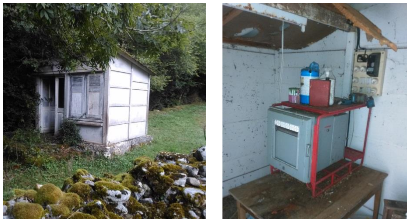
FIGURE 17 : LES ANCIENNES INSTALLATIONS POUR LA RECHERCHE DANS LA VALLEE DU BAGET
