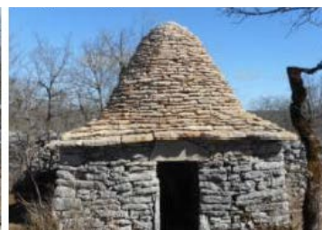
Le chantier terminé
