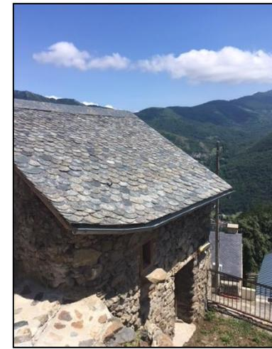
*Toiture en ardoise à pureau dégressif- Lapèges. ©PNRPA- CAUE*
