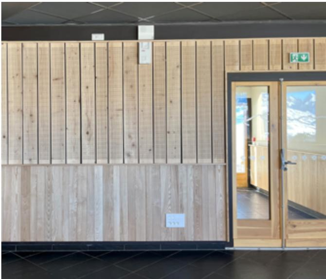
Panneaux acoustiques en sapin en partie supérieure des murs. Le sapin pectiné est de couleur claire et léger, mais moins résistant mécaniquement que le frêne, utilisé ici en partie inférieure pour protéger le bas des murs. Bâtiment d'accueil du plateau de Beille – Maître d'oeuvre : Triptyque. Photo : CAUE de l'Ariège
