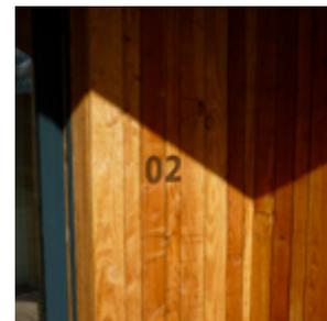
A lames larges, fines ou irrégulières, ces poses nécessitent un pare-pluie résistant aux UV et une pose soignée, qui prend en compte la rétraction des lames au séchage.
