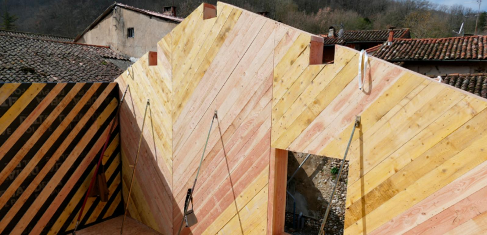
Contreventement réalisé avec de la volige posée en oblique - L'Estanquet à Pailhès.
