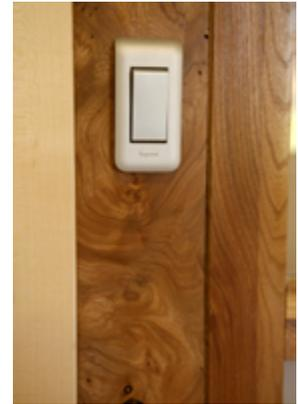
Utilisation de l'orme et du noyer pour la structure recevant les menuiseries intérieures – Ferme d'Icart à Montels.
