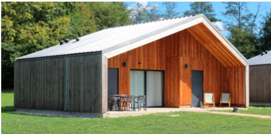
Le bardage grise différemment selon l'orientation mais de manière uniforme du fait de la conception architecturale : l'intégration des gouttières et des descentes d'eau pluviale permet d'éviter les débords de toiture et autres redans pouvant créer des ombres portées sur le bardage et altérer l'homogénéité de son grisaillement.
