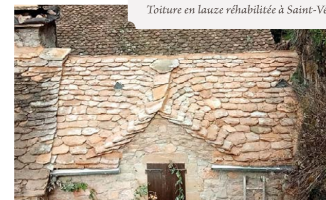
Toiture en lauze réhabilitée à Saint-Véran
