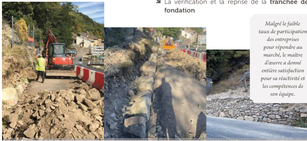
Jour 1 Préparation, purge, tri des pierres, fondations
