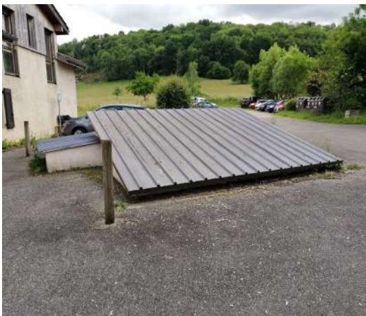
(a) Vue extérieure du silo à biomasse.
