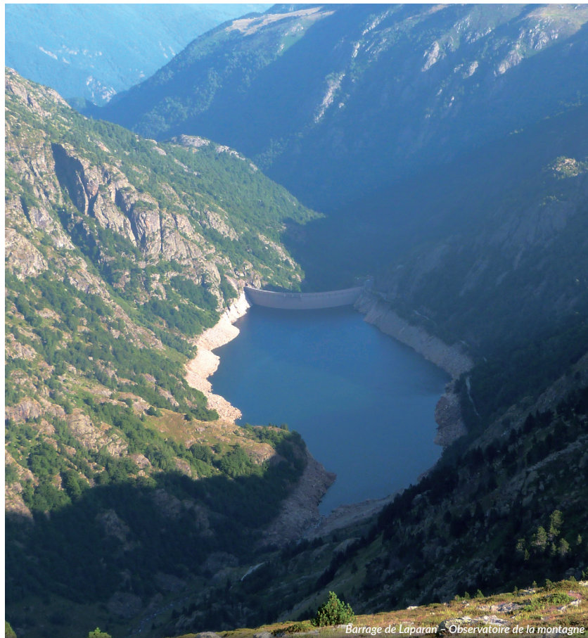
Barrage de Laparan - Observatoire de la montagne
